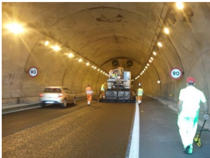
Fotografía 14: Extensión Microaglomerado en frío en túnel.
