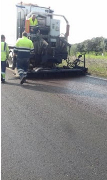
Fotografía 19: Extensión de Microaglomerado en frío.
