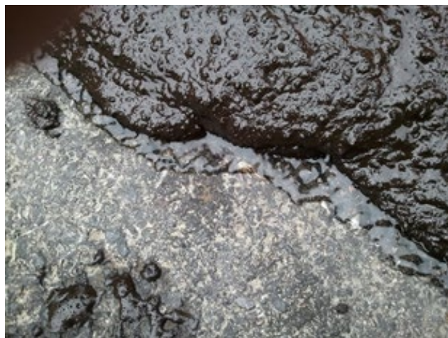
Fotografía 3: Detalle del curado de un microaglomerado en frío
