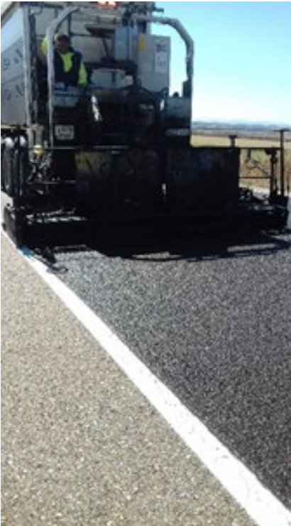
Fotografía 10: Extensión de microaglomerado en frío.
