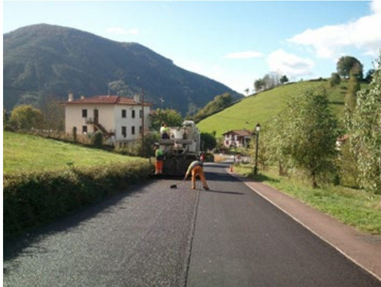
Fotografía 20: Extensión de Microaglomerado en frío.
