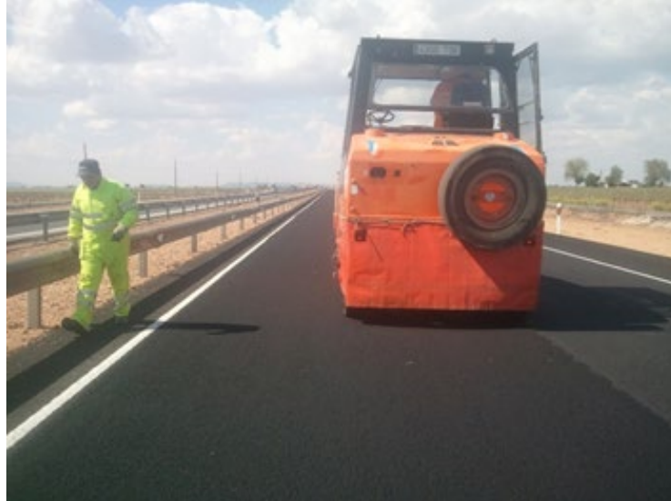
Fotografía 48.- Detalle de la compactación de un microaglomerado en frío.
