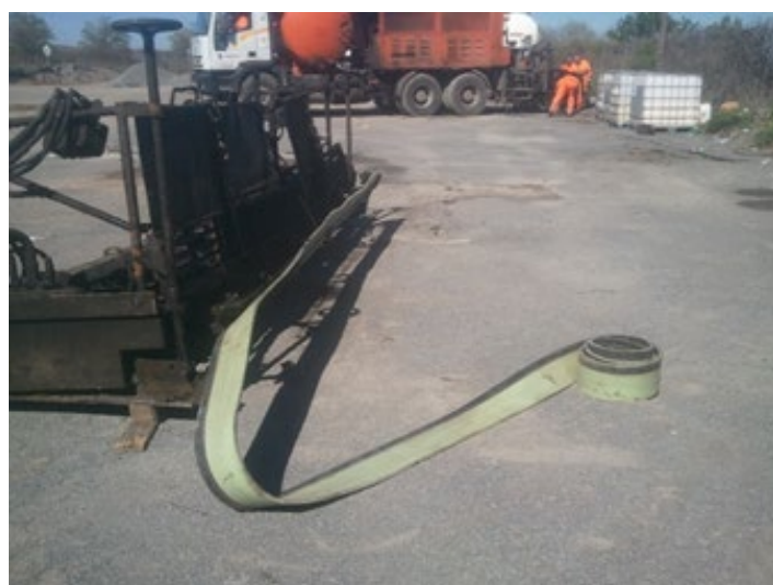
Fotografía 39. - Colocación de la goma maestra en el cajón repartidor.
