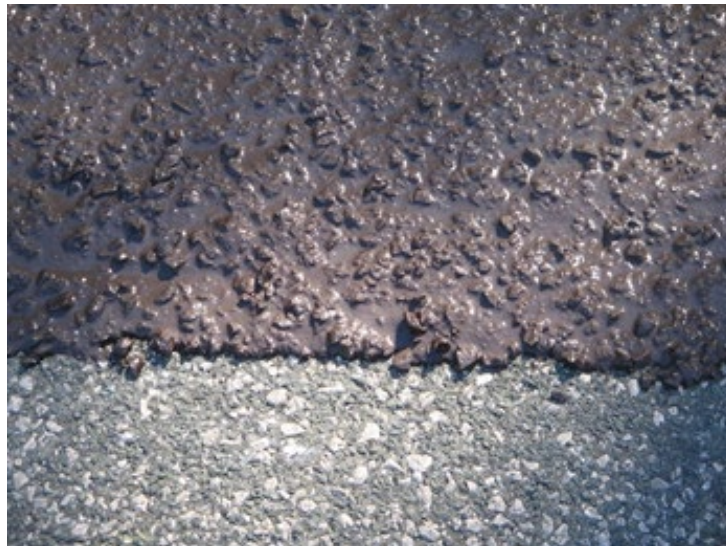
Foto 17: Detalle de la macrotextura de un Microaglomerado en frío.
