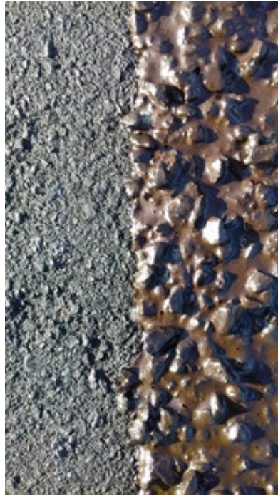
Fotografía 18: Detalle de la macrotextura de un Microaglomerado en frío grueso.
