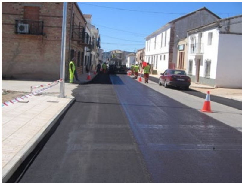
Fotografía 15: Extensión Microaglomerado en frío en travesía.
