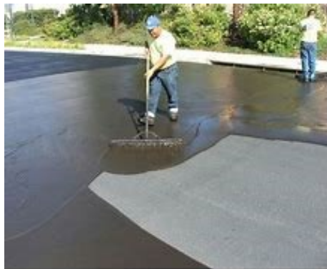
Fotografía 2: Aplicación manual de una lechada bituminosa
