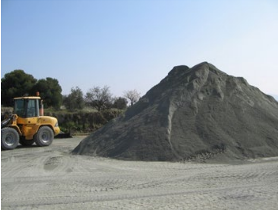
Fotografía 21: Acopio de árido
