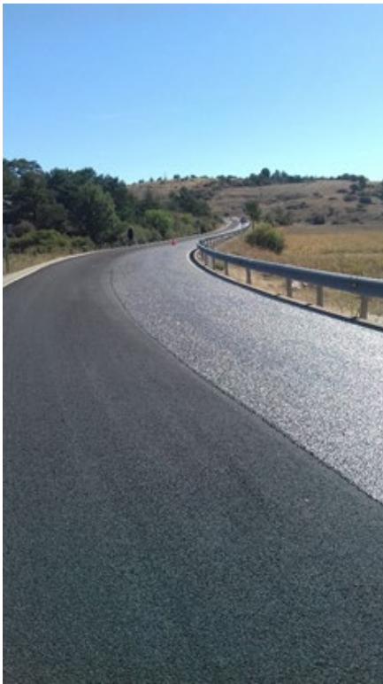
Fotografía 9: Protección del firme mediante microaglomerado en frío.
