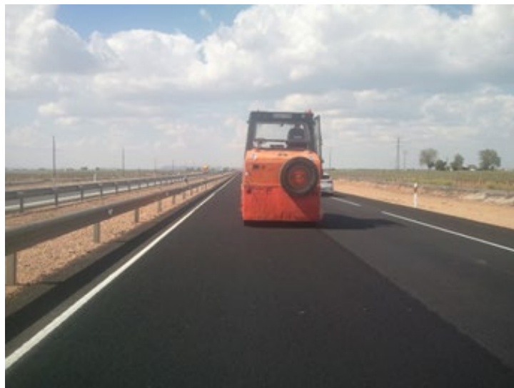
Fotografía 4: Aspecto final de un microaglomerado en frío
