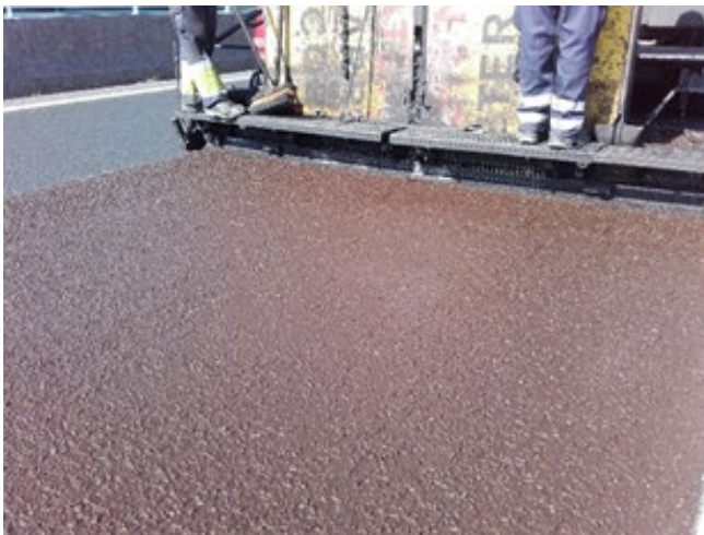
Fotografía 45.- Detalle de la extensión de microaglomerado en frío.
