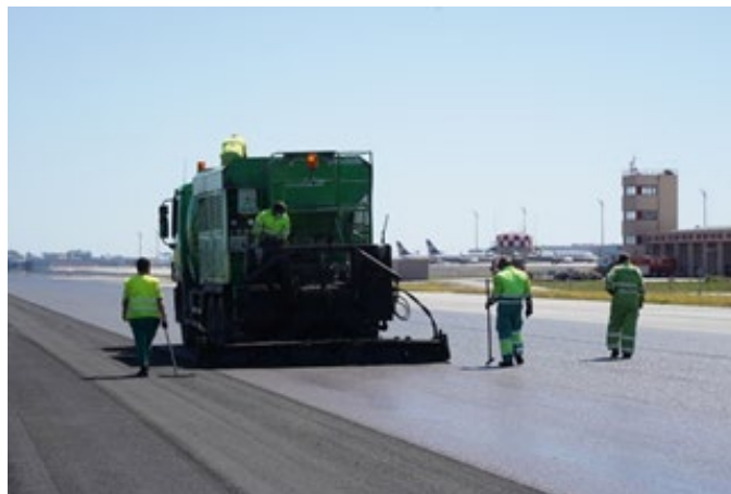
Foto 12: Extensión de microaglomerado en frío en pista de aeropuerto.
