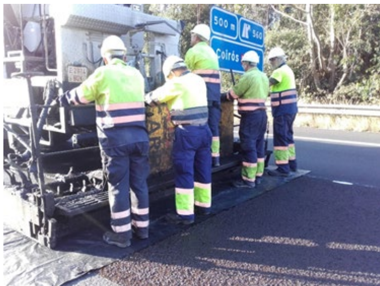
Fotografía 51. - Detalle de los EPIs de los trabajadores.
