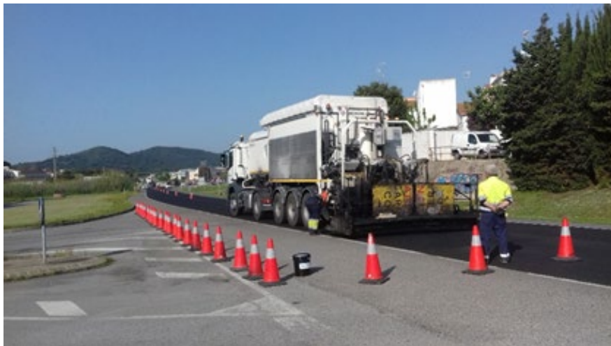
Fotografía 49.- Detalle de la señalización.
