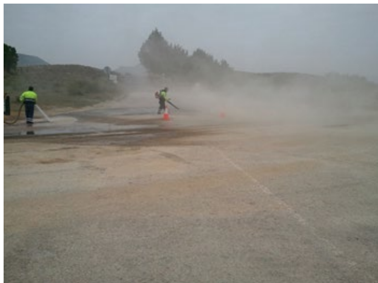
Fotografía 42.- Detalle de la limpieza del soporte.
