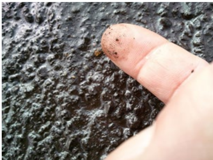
Fotografía 44.- Detalle de la toma de cohesión de la mezcla en obra.
