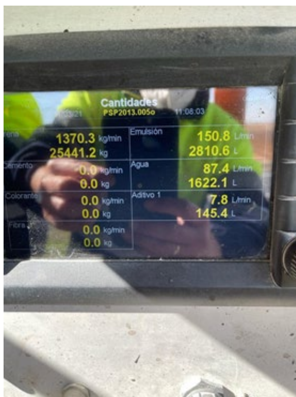
Fotografía 43.- Detalle de la dosificación en el equipo de fabricación y extendido.
