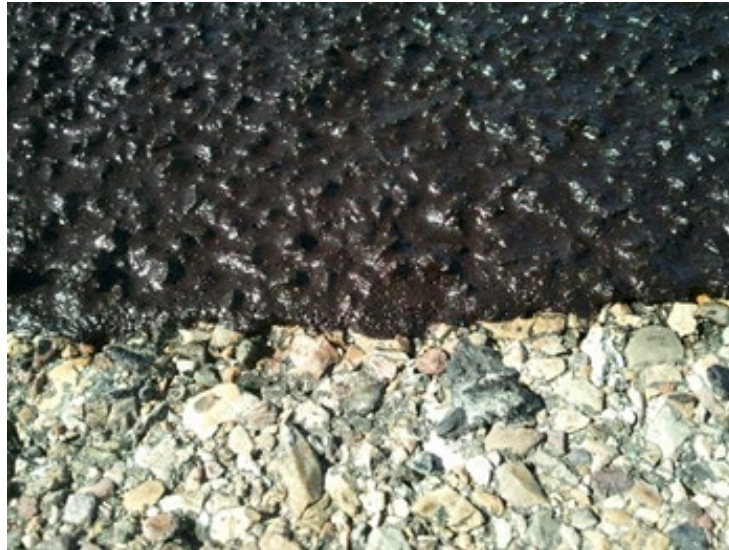
Fotografía 11: Detalle macrotextura de un microaglomerado en frío.
