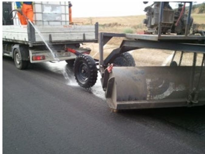
Fotografía 41.- Detalle de la limpieza del soporte.
