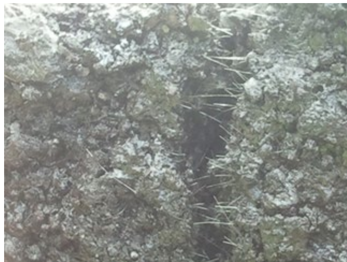
Fotografía 26: Detalle de la distribución de las fibras en la mezcla.
