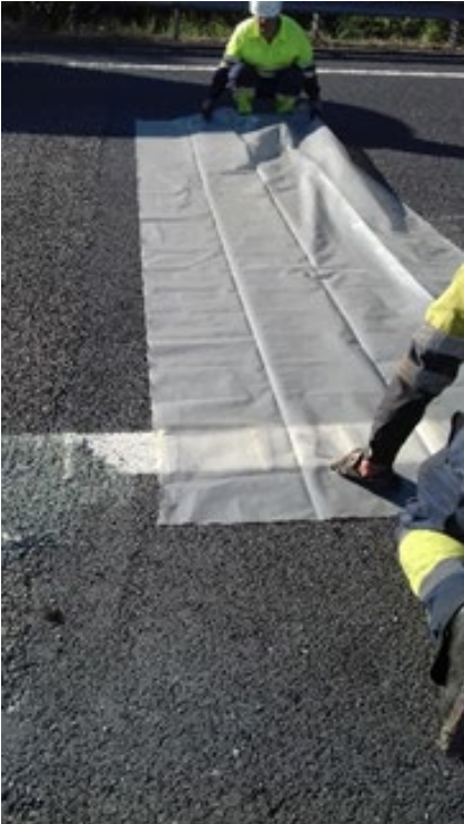
Fotografía 46.- Detalle de la colocación de la banda de plástico.
